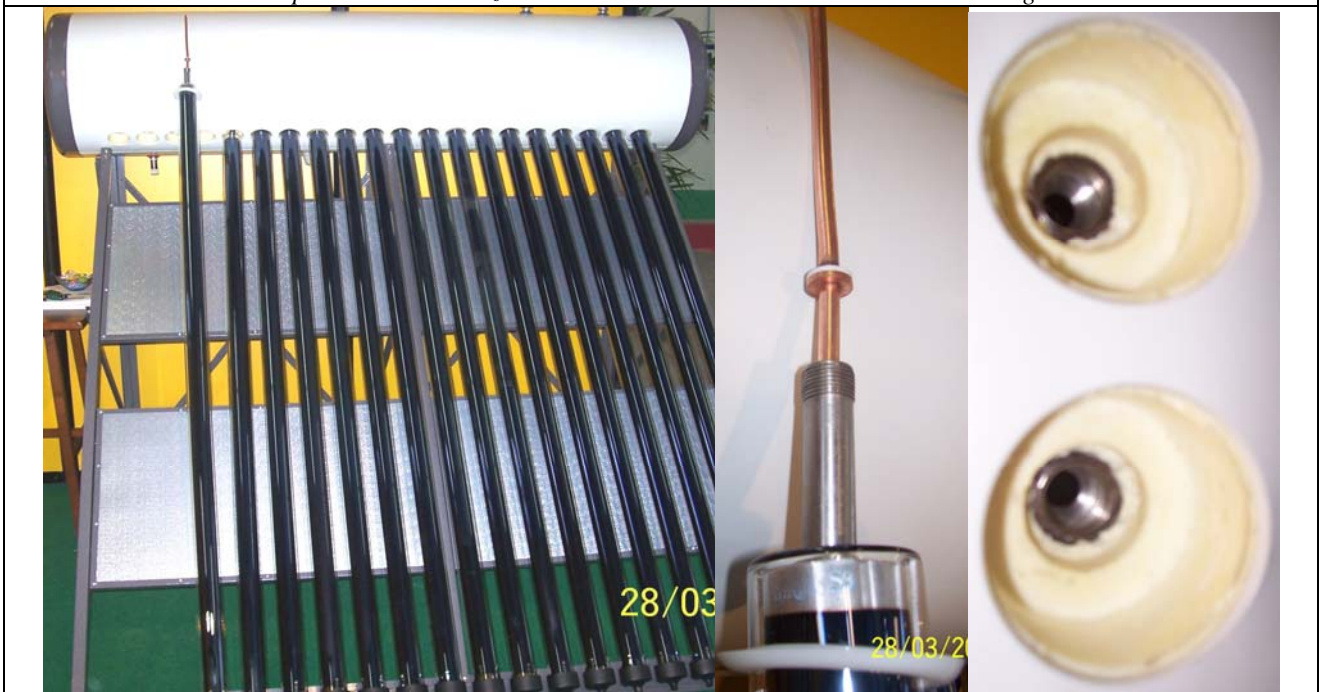
Il pannello a circolazione Naturale con tubi sottovuoto ed alcuni dettagli
